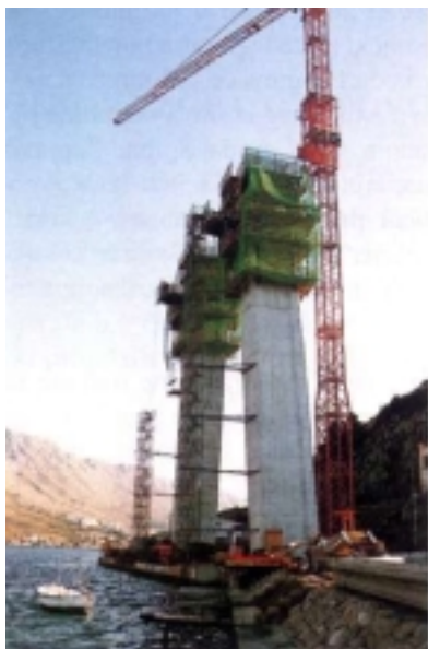
Pilon A u gradnji
