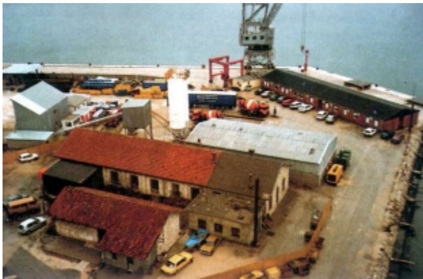
Gradilišna uprava i skladišta snimljeni s pilona u gradnji
