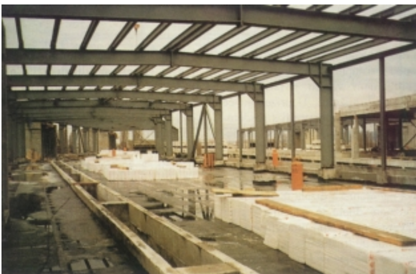
Čelična konstrukcija strojarnice
