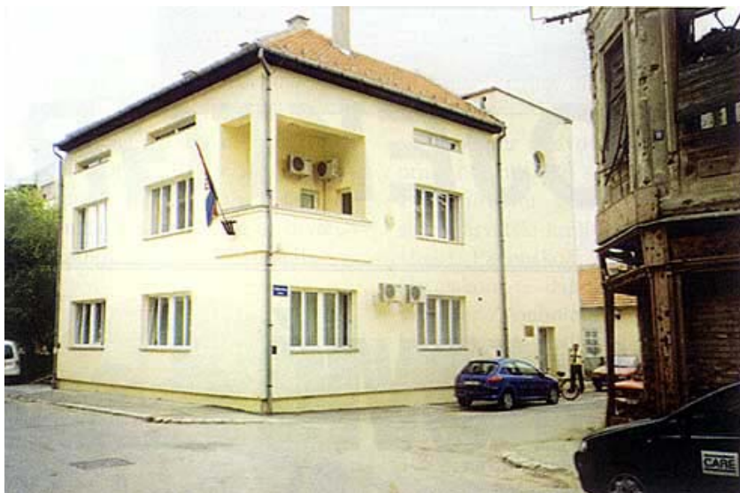
Obnovljena zgrada Zavoda za zapošljavanje
