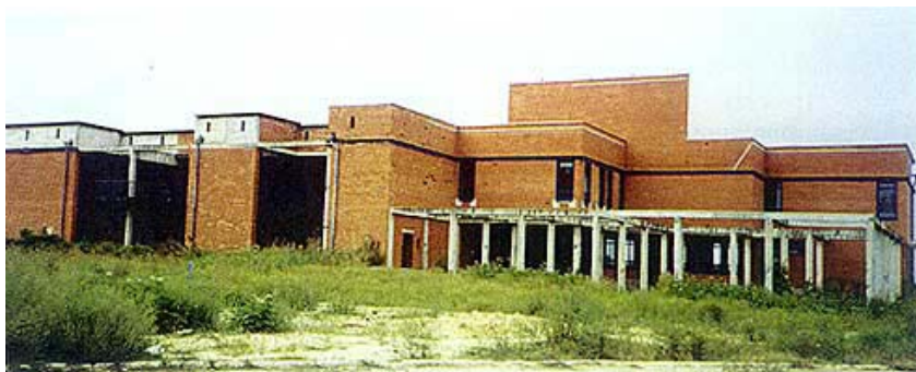
Zgrada 3. srednje škole (bivše OŠ Borovo naselje )
