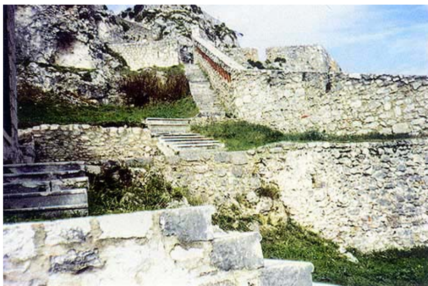
Obrambeni zidovi i stube prema Bandjeri
