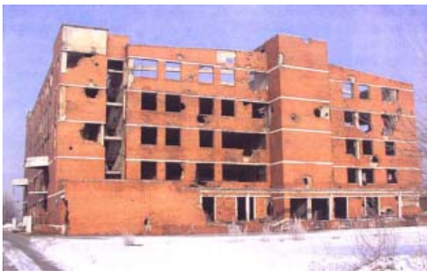
Zgrada Borovo-Comerca prije rušenja
