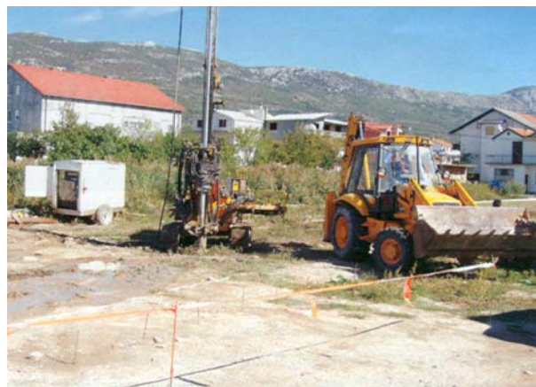
Slika 3. Radovi na zaštiti starog kanala i postavljanju posljednjih 50 m cjevovoda
