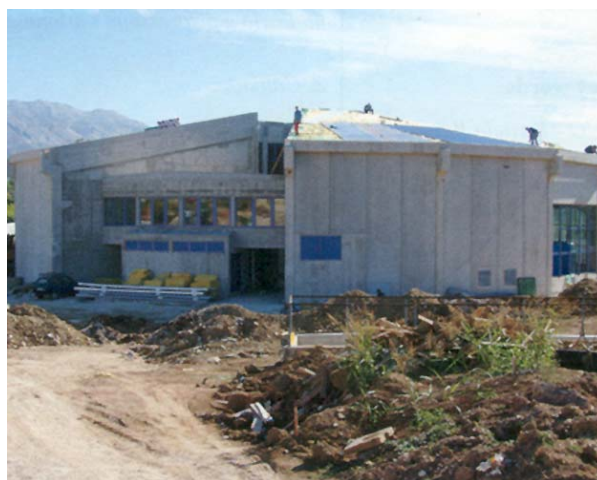
Slika 1. Crpna stanica Ravne Njive u izgradnji
