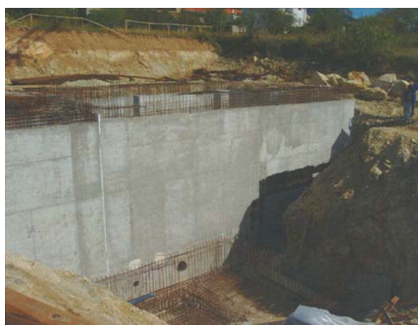
Slika 6. Radovi na vodospremi za CS Solin i podsustav Sv. Kajo
