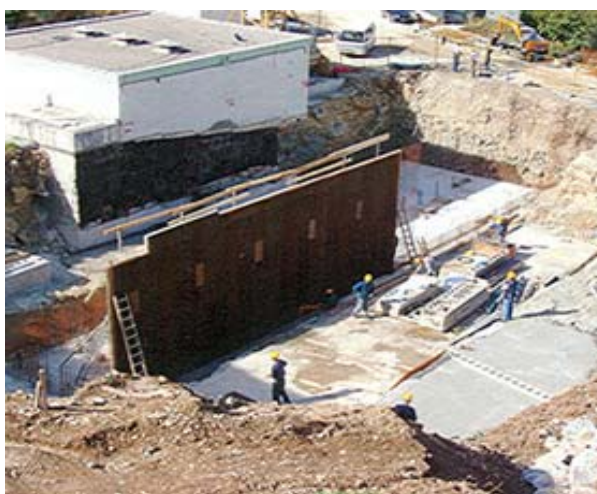
Slika 2. Gradnja crpne stanice Kunčeva Greda
