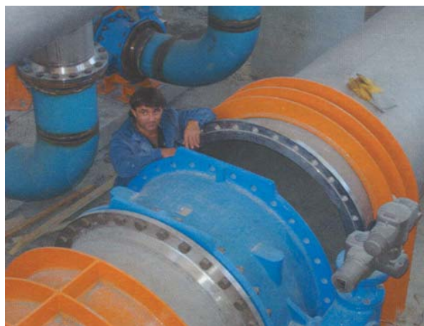
Slika 5. Montaža crpki crpne stanice Ravne Njive
