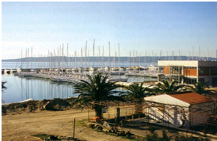
Građevinski radovi u marini
