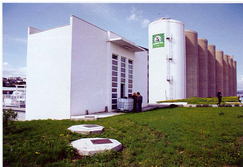
Zgrada uređaja za predtretman otpadnih voda Jadranske pivovare
