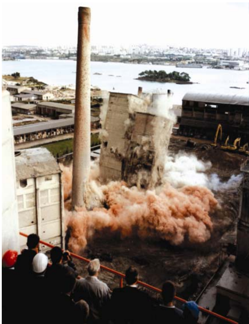
Rušenje specijalnim strojevima 250 m visokog dimnjaka koksare u Bakru
