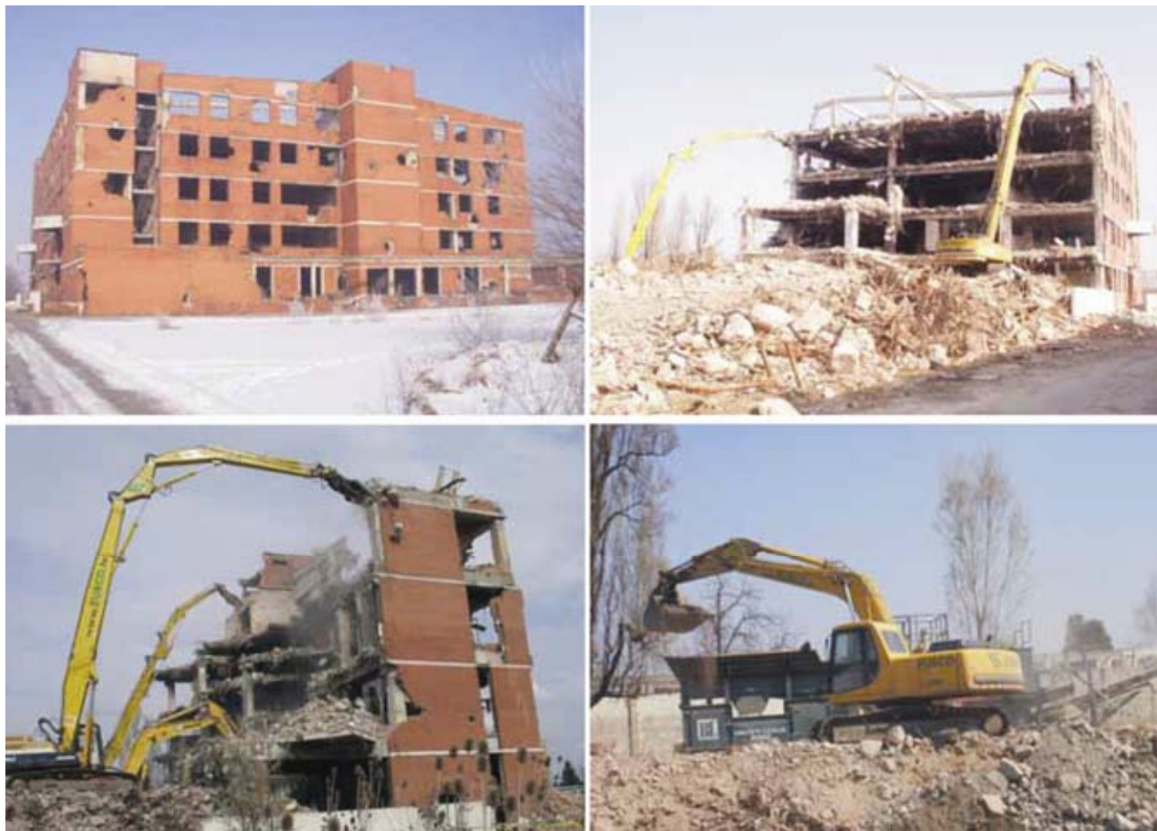
Faze rušenja građevine Borovo-Commerce u Vukovaru
