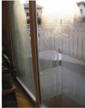
Primjeri kondenzacije na suvremenim energetski učinkovitim ostakljenjima: lijevo - na donjem rubu unutarnjega stakla u području distancera do kojega često dolazi noću u zagrijanim prostorima, a uzrokuje probleme drvenom okviru, desno - na većem dijelu unutarnjega stakla siguran znak prevelikoga opterećenja prostora vlagom
