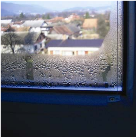
Primjeri kondenzacije na suvremenim energetski učinkovitim ostakljenjima: lijevo - na donjem rubu unutarnjega stakla u području distancera do kojega često dolazi noću u zagrijanim prostorima, a uzrokuje probleme drvenom okviru, desno - na većem dijelu unutarnjega stakla siguran znak prevelikoga opterećenja prostora vlagom
