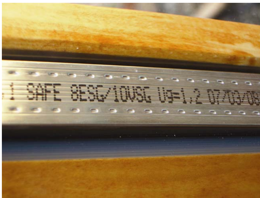
Karakteristike ostakljenja i datum izrade napisan na distanceru između stakla
