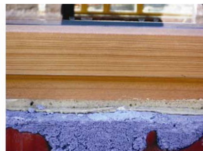
Detalj klasične ugradnje prozora s montažnom pjenom na: a) drvenu i b) masivnu konstrukciju
