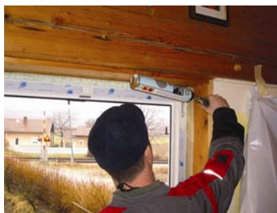
Detalj klasične ugradnje prozora s montažnom pjenom na: a) drvenu i b) masivnu konstrukciju
