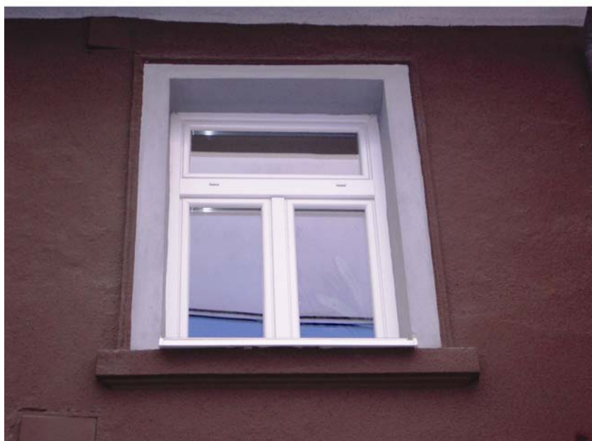
Primjer loše i dobre prakse pri izmjeni prozora: gore – nakon obnove zaštićenoga pročelja, dolje – zajedno s obnovom pročelja
