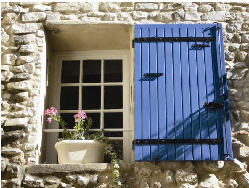
Stari drveni prozor pravilno ugrađen
