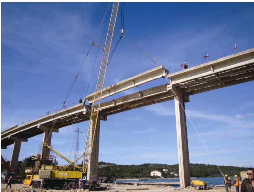
Demontaža prvog nosača na mostu
