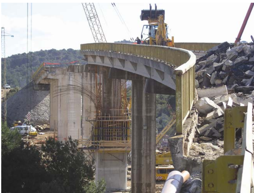
Most tijekom rekonstrukcije
