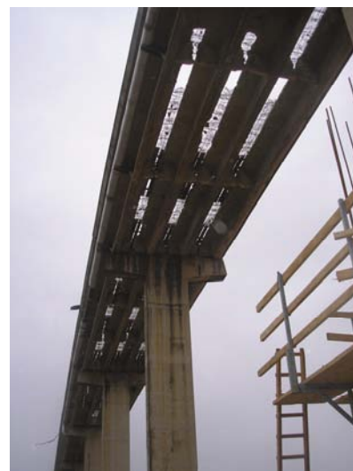
Pogled odozdo na nosače bez kolničke ploče
