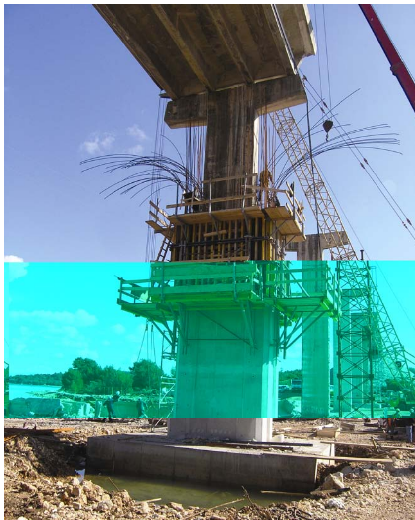
Ojačavanje nosivoga stupa čelične konstrukcije
