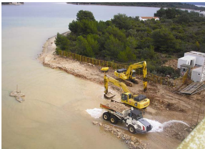
Početak iskopa u morskom prolazu
