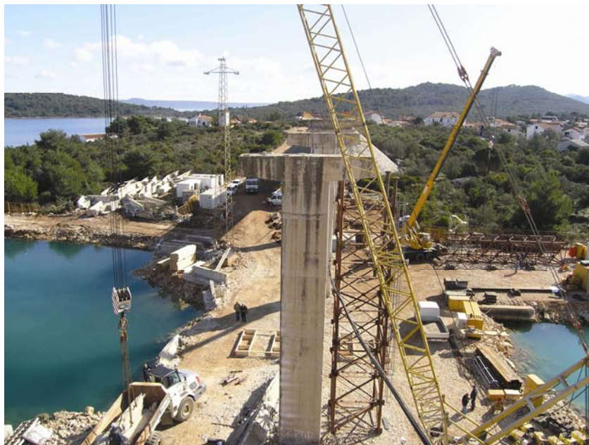
Pogled na gradilište s vrha armiranobetonskog dijela mosta
