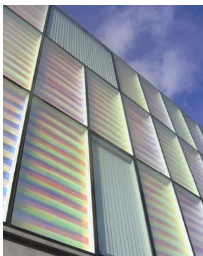
Dikromična stakla na pročelju stambenoga bloka u Londonu
