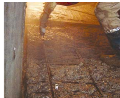
Nanošenje sanacijskog morta Mapegrouta T60
