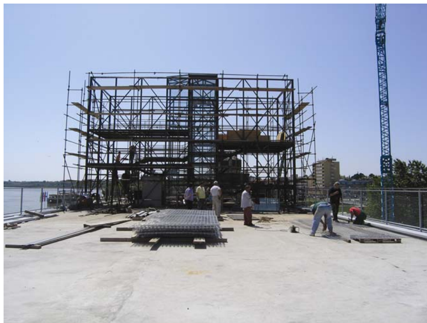
Radovi na gradnji vidikovca
