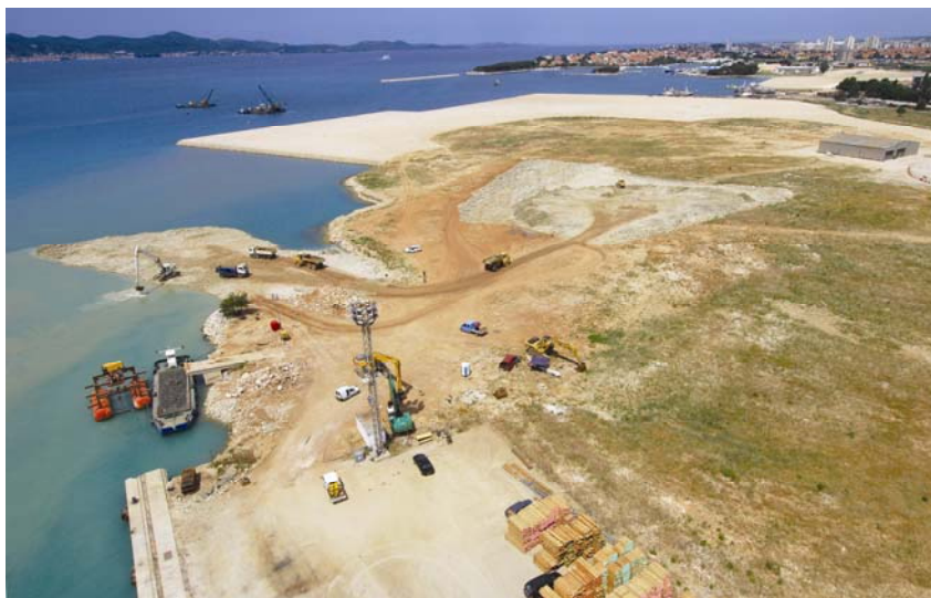
Sadašnji radovi na gradnji novoga trajektnog terminala
