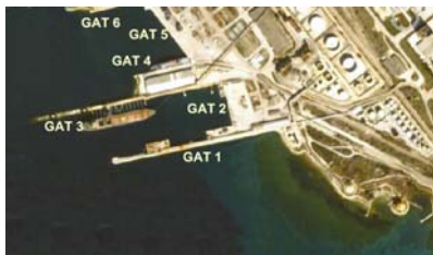
Postojeća teretna luka Gaženica s označenim gatovima
