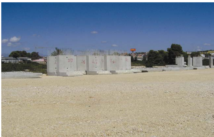
Početak izrade armiranobetonskih blokova
