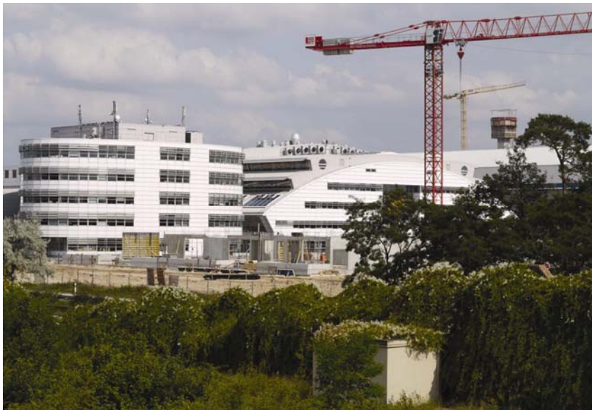
Gradilište Lufthansinog centra za letačku obuku
