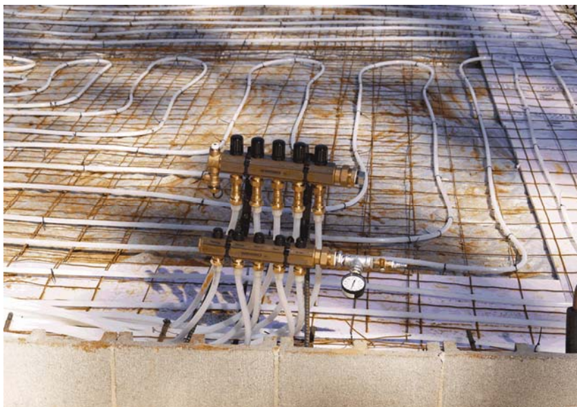
Provjera sustava podnog grijanja prije završetka poda
