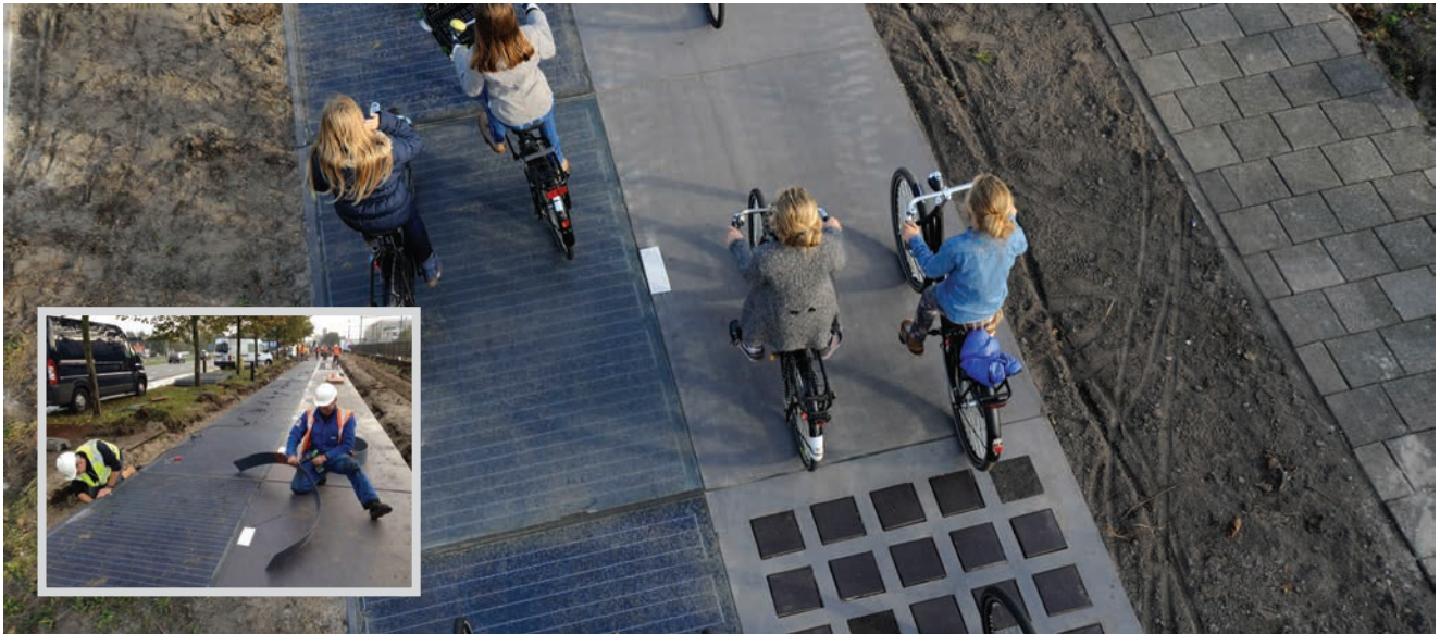
Ugradnja fotonaponskih panela (mala slika) i ispitivanje solarne biciklističke staze
