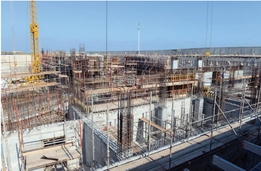
Detalj s gradilišta
