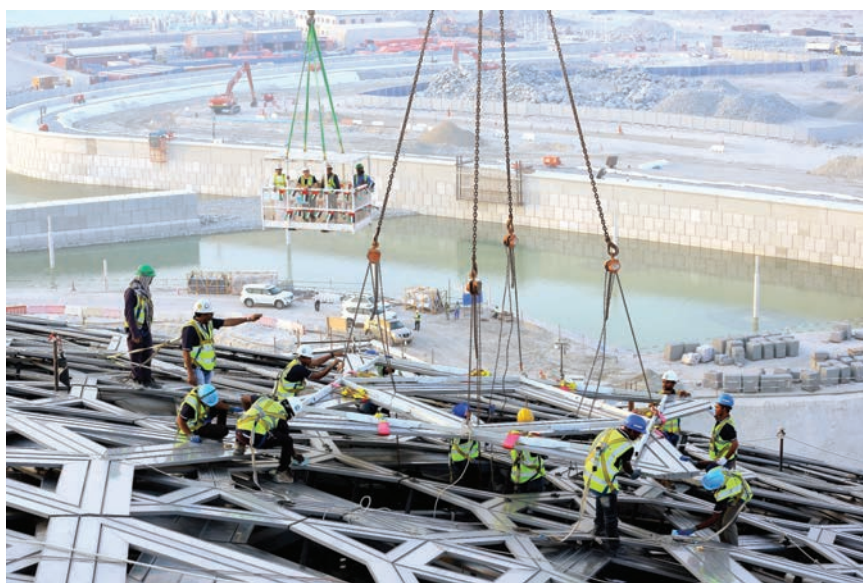
Ugradnja zadnjeg sloja kupole
