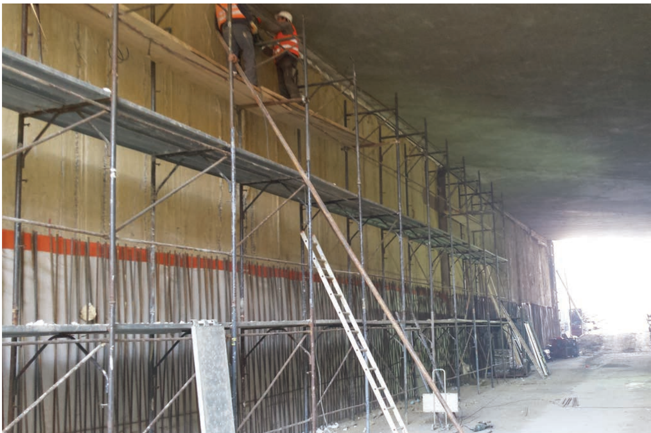
Uređenje dijafragme prije izrade obložnih zidova
