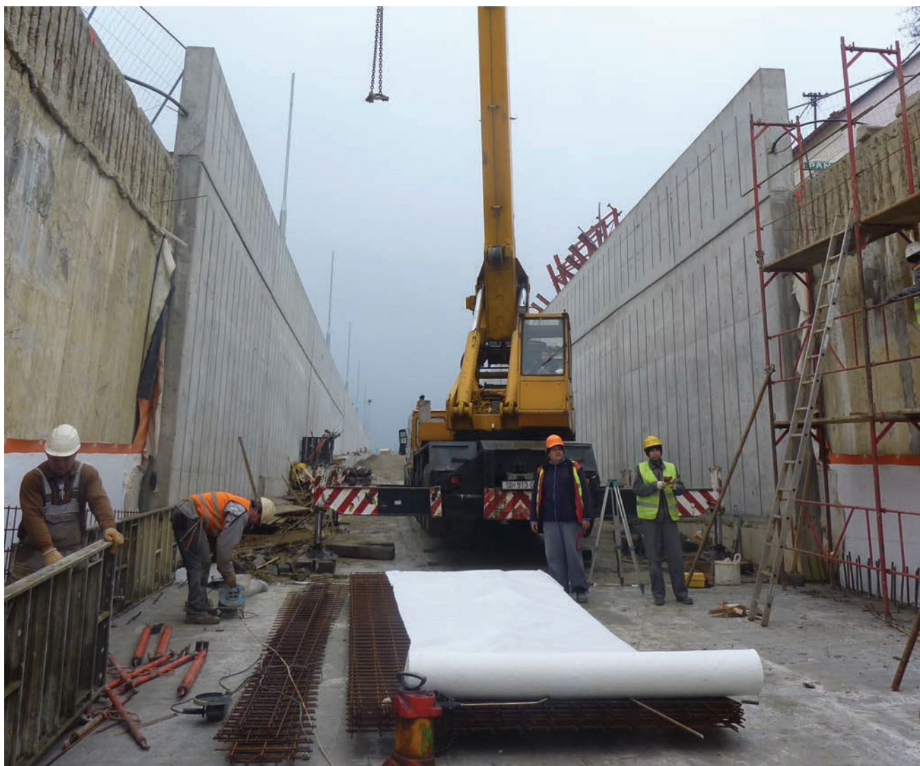
Detalj s gradilišta
