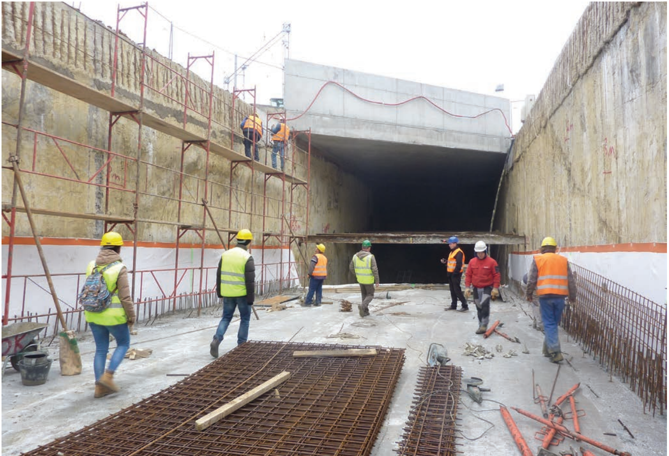
Postavljanje armature razuporne ploče
