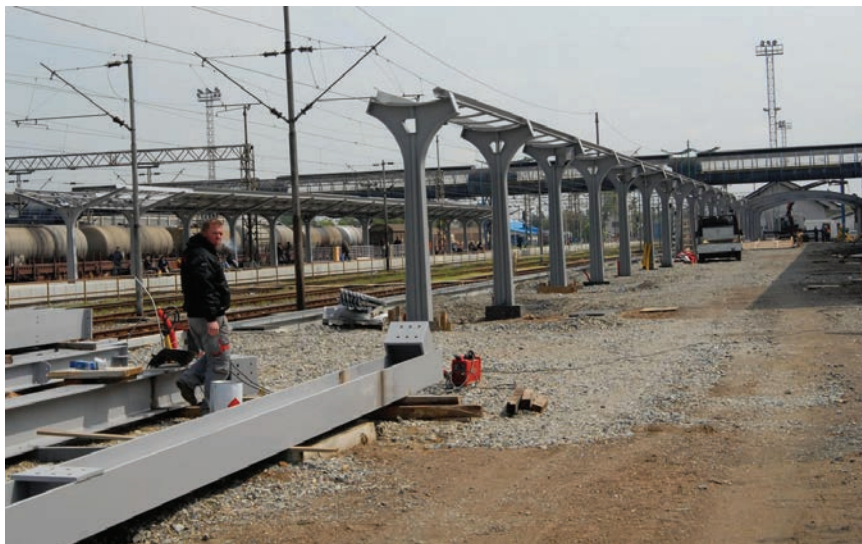
Radovi tijekom rekonstrukcije željezničkog kolodvora
