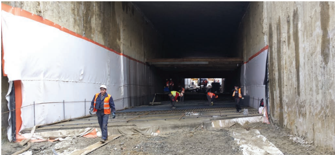
Oblaganje zidova budućeg podvožnjaka
