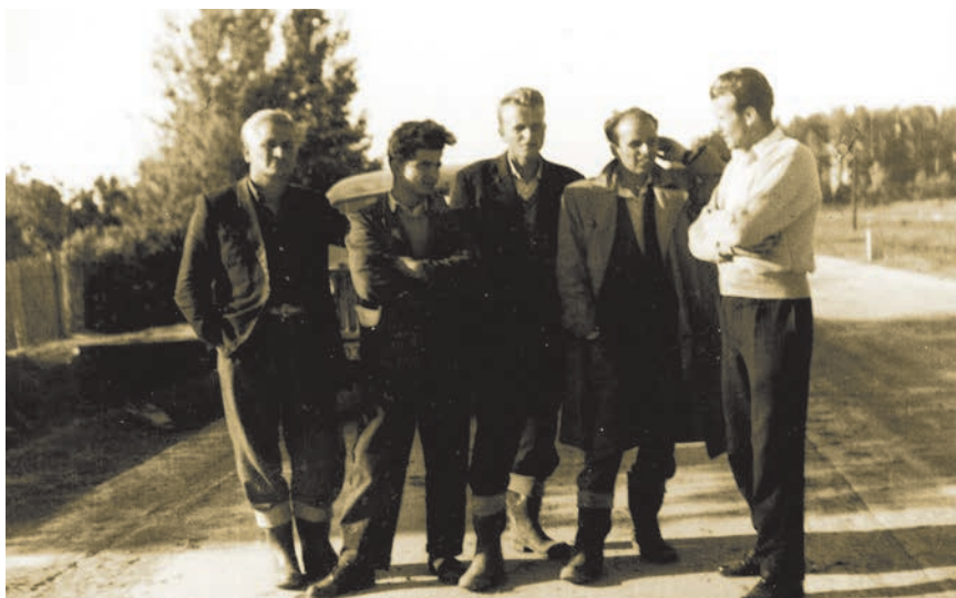
Snimljeno na gradilišta vijadukta Kopanica 1955., prije nego što je počeo raditi u Hidroprojektu (Z. Blažević, drugi s desna)
