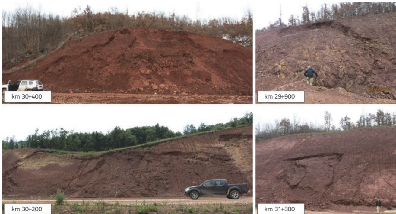
Slika 2. Tipični lomovi u permskom šejlu i mulnjaku
