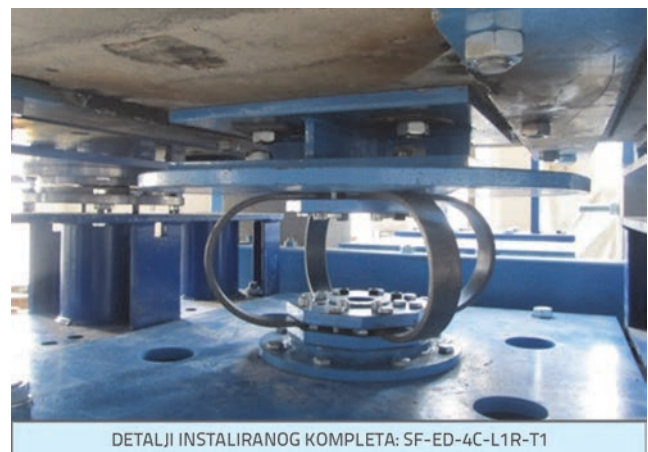
Slika 20. Izrađeni i instalirani komplet sastavljen od dva uređaja DRSRB i jednog uređaja SF-ED-4C-L1R-T1 na desnoj krajnjoj potpori ispitivanog modela prototipskog mosta
