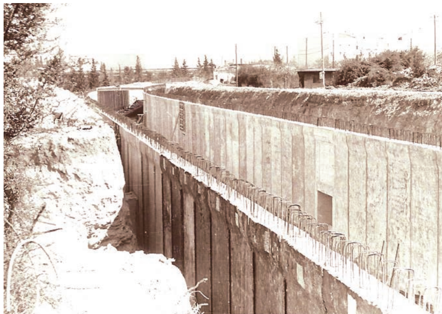
Detalj tijekom druge faze gradnje tunela
