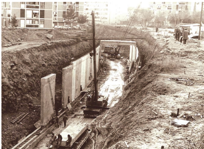
Detalj s gradilišta željezničkog tunela 1979.
