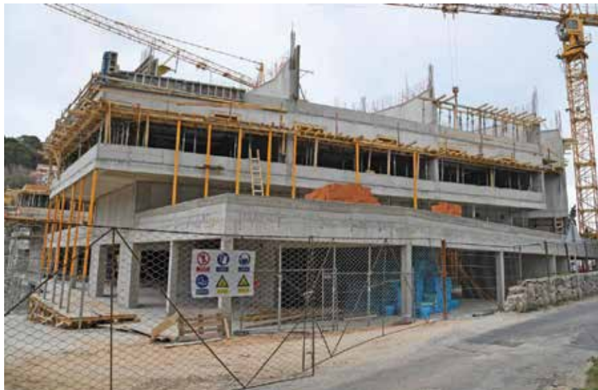
Armiranobetonski radovi na drugoj etaži
