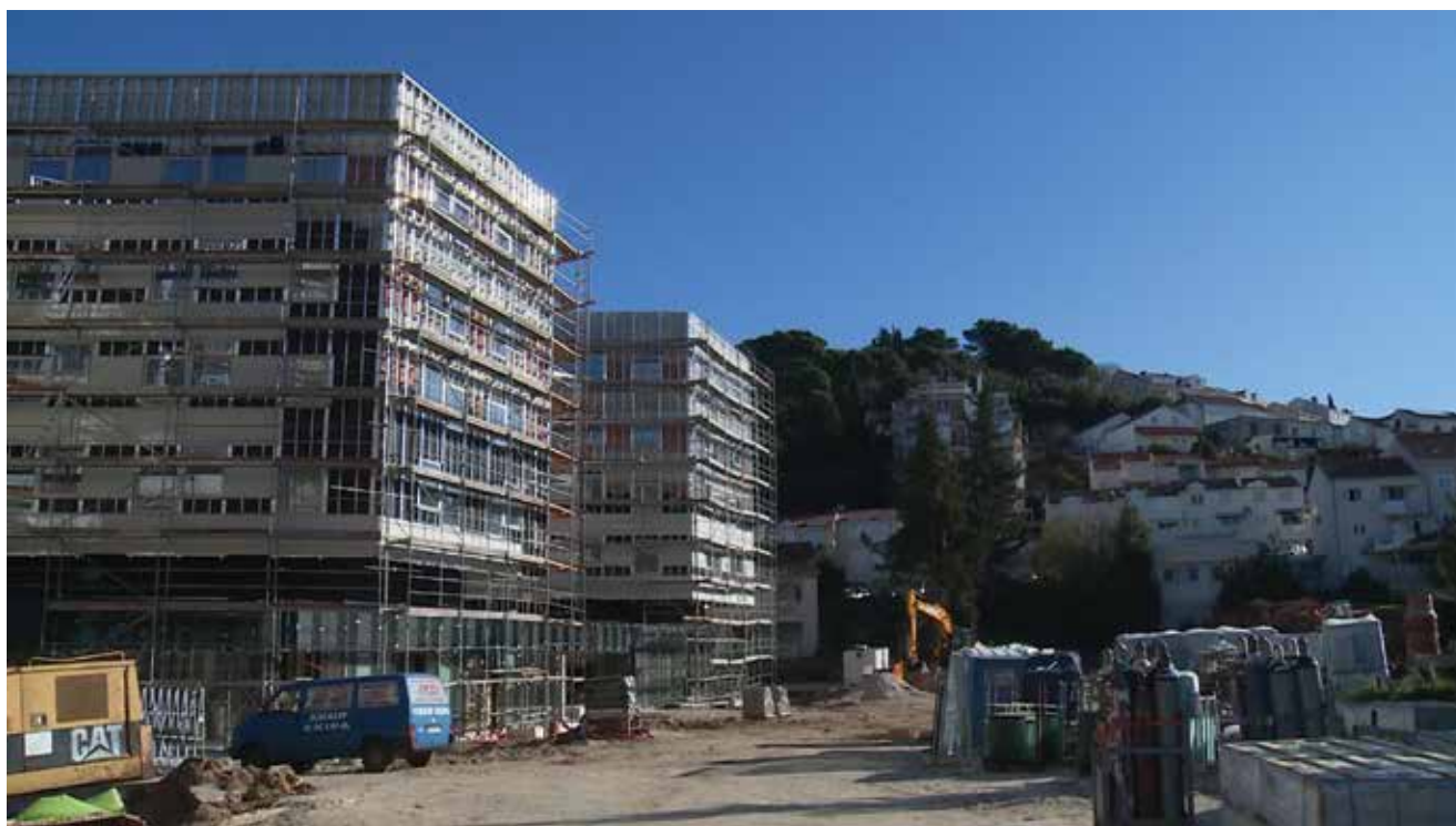
Detalj s gradilišta
