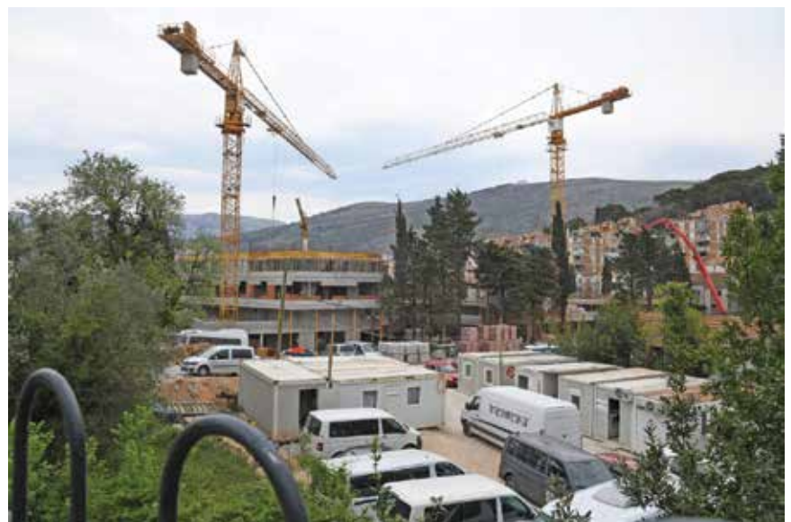
Pogled na gradilište
