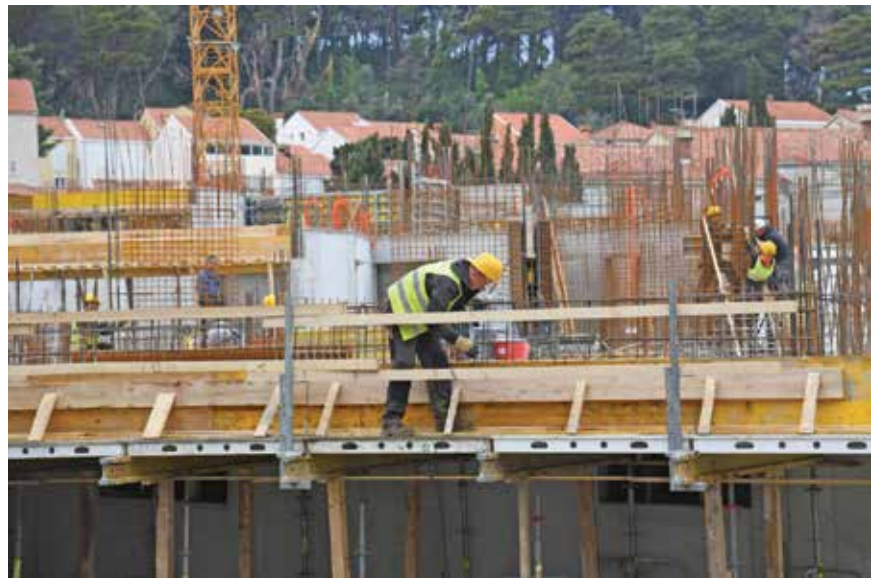
Detalj snimljen tijekom radova na zadnjoj, četvrtoj etaži
