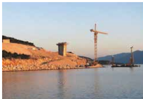
Slika 4. Gradilište mosta Pelješac 2009. godine
