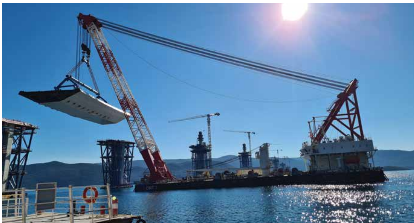
Slika 12. Montaža elemenata pristupnih raspona
