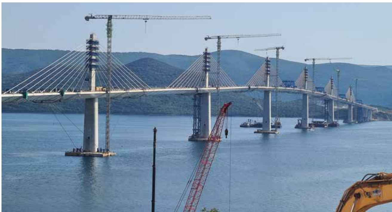
Slika 15. Montaža rasponskog sklopa – zadnji spojni segment
