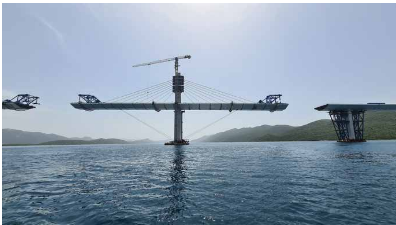
Slika 14. Montaža rasponskog sklopa – pilon S10
