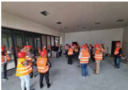
Obilazak gradilišta knjižnice u Vinkovcima
