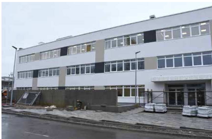
Detalj s gradilišta škole (Foto: Nikola Cutuk/PIXSELL)
