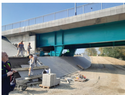
Završni radovi na mostu
