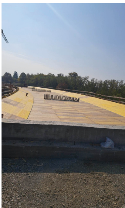
Postavljanje oplata na mostu
