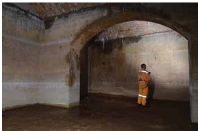
Postojeće stanje – zidovi nekadašnje gusterne
