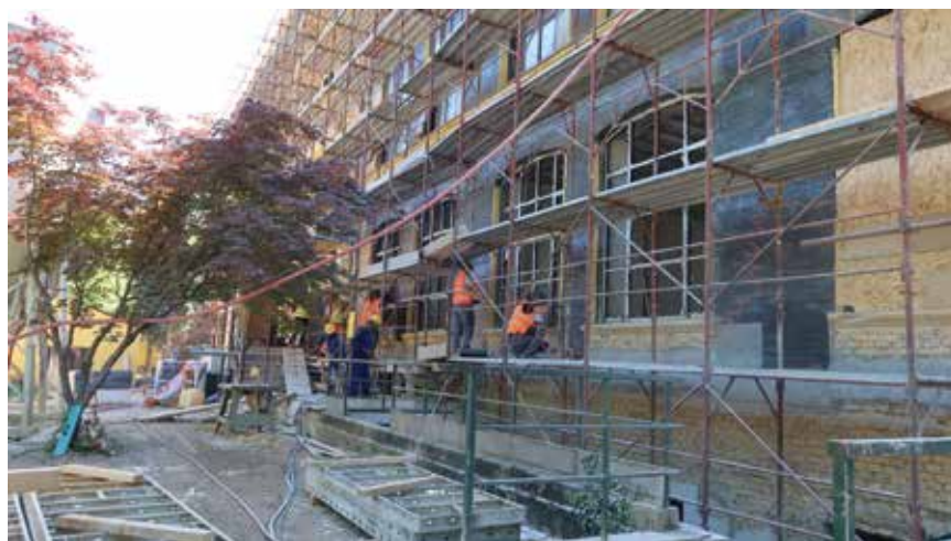
Obnova fasade na zgradi u Ilici 85
