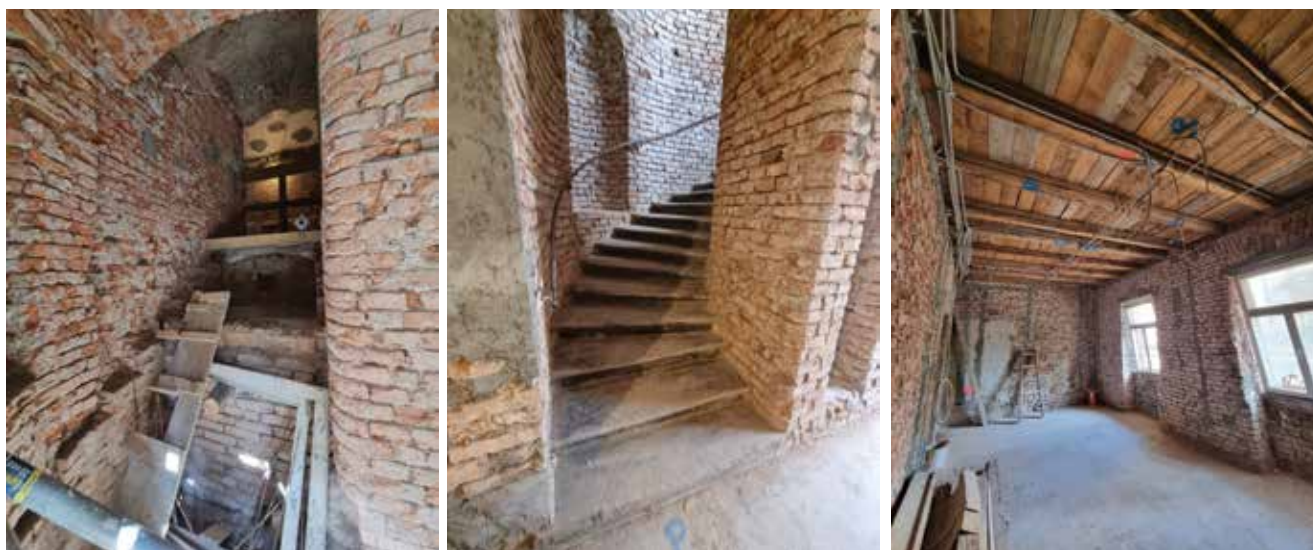
Detalji s gradilišta zgrade u Ilici 83
