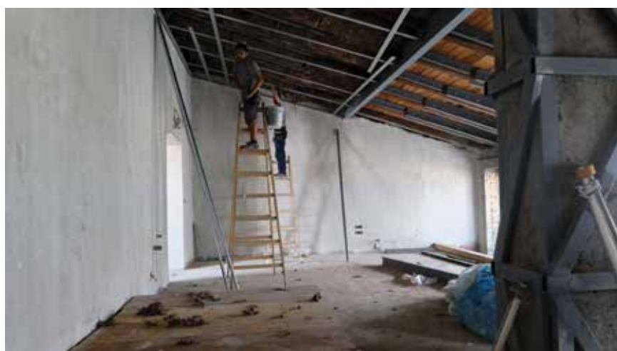
Radovi obnove na zgradi u Ilici 85
