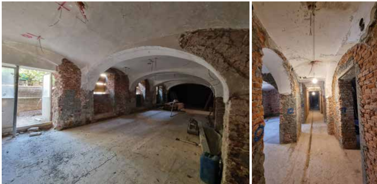
Početak obnove na zgradi u Ilici 83
