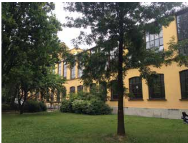
Zgrada ALU, Ilica 85 prije obnove
