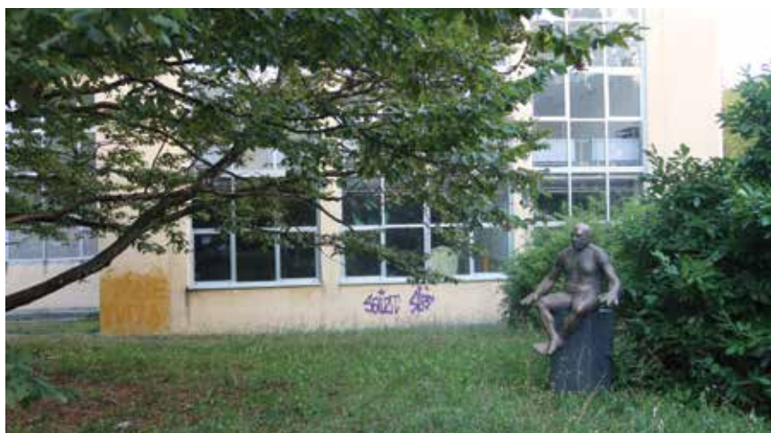
Pogled na zgrade na Jabukovcu prije početka radova na obnovi
