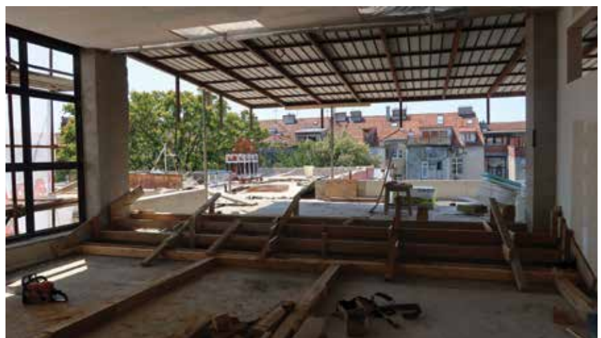
Početak obnove na zgradi u Ilici 85
