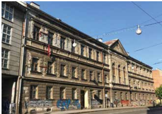
Fasada zgrade prije početka radova u Ilici 83
