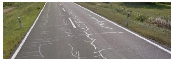
Slika 4. Temperaturne pukotine na D28, bjelovarskoj obilaznici, od km 7+000 do km 7+500
