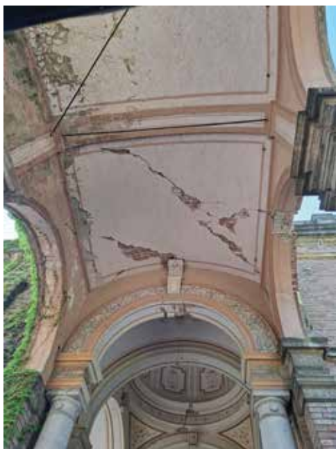
Slika 1. Oštećenja konstrukcije uslijed izvanrednih djelovanja potresa u Zagrebu i kod Petrinje 2020. na primjeru Mirogojskih arkada (autor: Davorin Penava)
