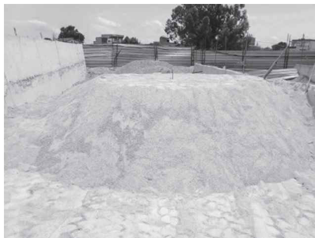
Slika 6. CMA sidro ugrađeno u pijesak
