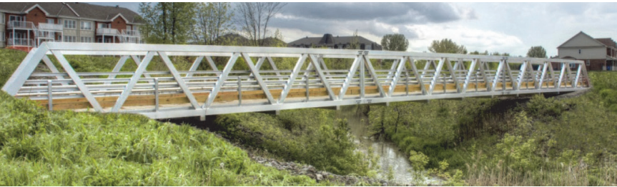
Slika 5. Aluminijски pješački most, Brossard, Kanada [12]
