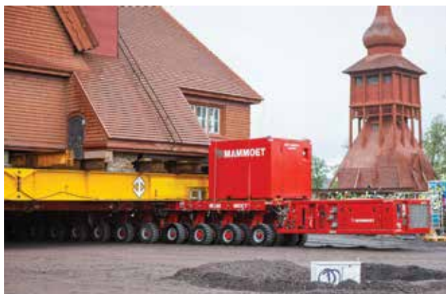
Podizanje crkve na samohodne modularne transportere (Foto: ATP)
