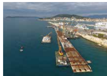
Gradnja vanjskih vezova u luci
