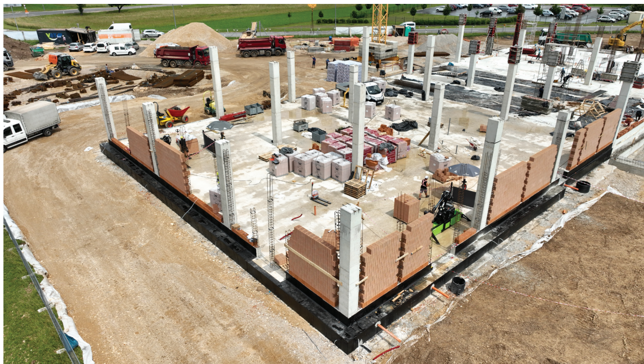
Pogled na gradilište s pilot primjenom WLTR robota za zidanje - trgovački centar Cerklja ob Dravi, Slovenija
