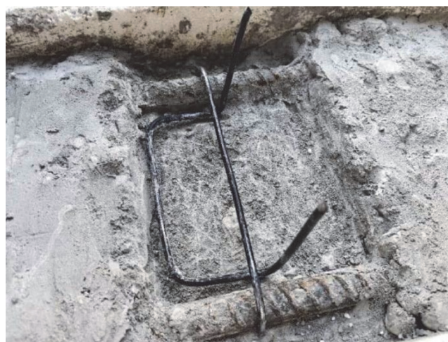
Slika 3. Postavljanje spojnica
