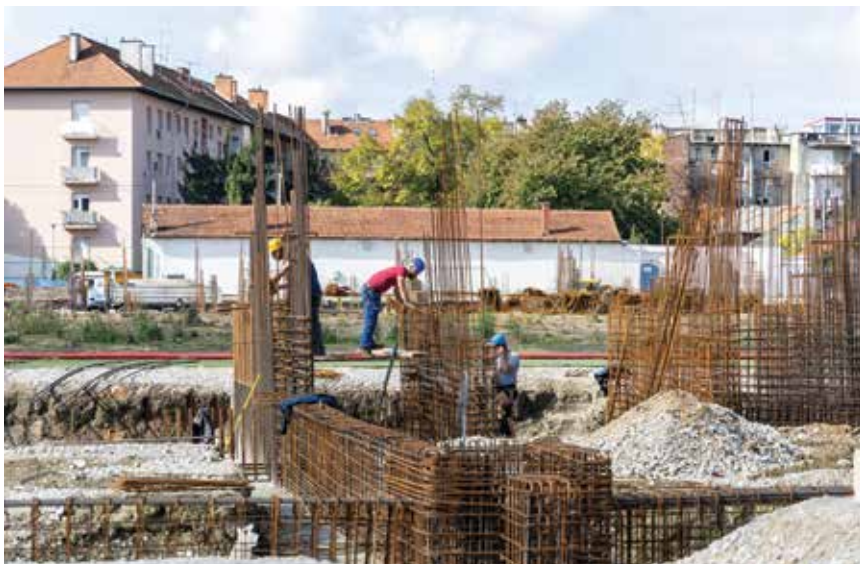
Armirački radovi za konstrukciju tribina
