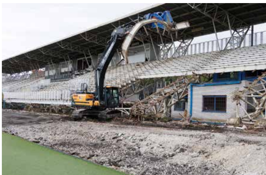
Rušenje tribina na stadionu
