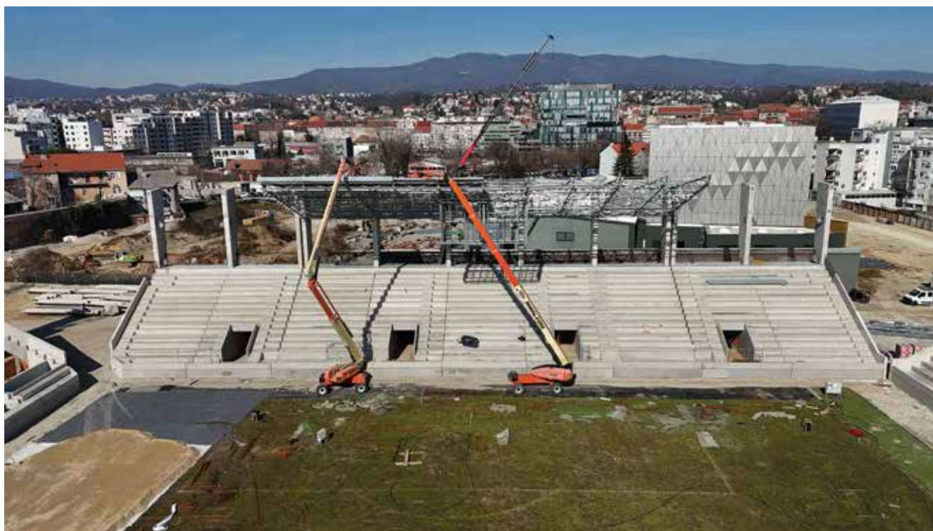
Montaža krovne konstrukcije na sjevernoj tribini
