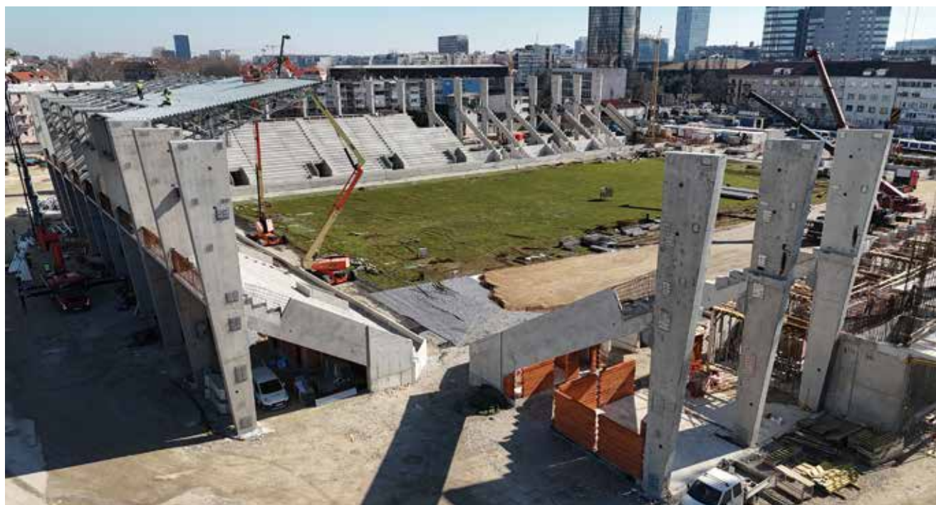
Detalj s gradilišta
