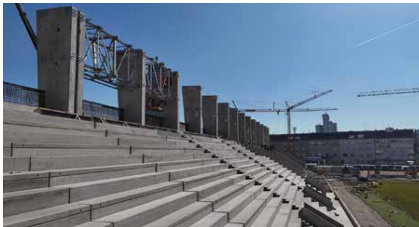
Pogled na nove tribine, prije ugradnje krovne konstrukcije
