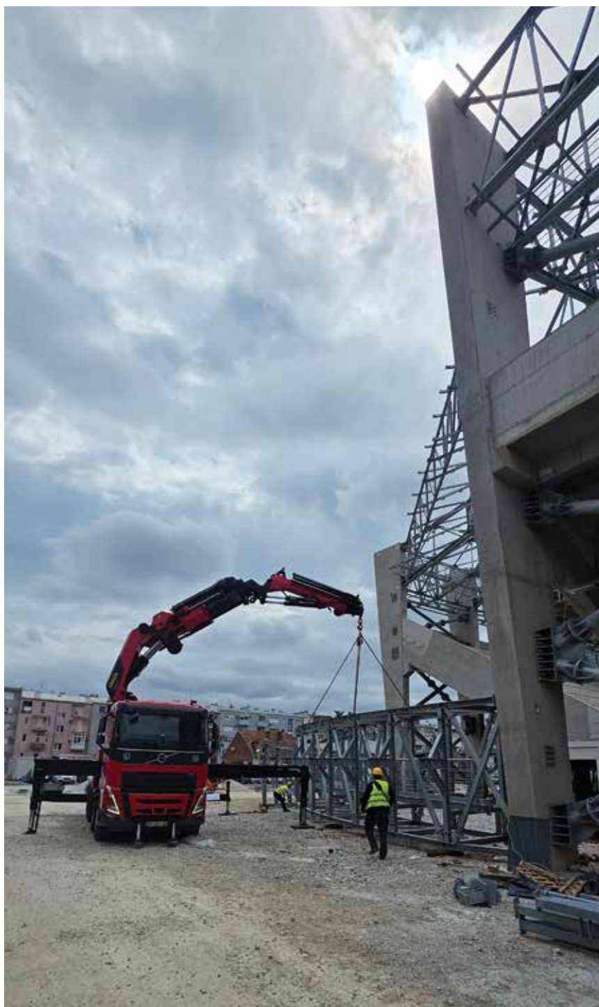
Montaža lučne čelične krovne konstrukcije u kutnom dijelu stadiona
