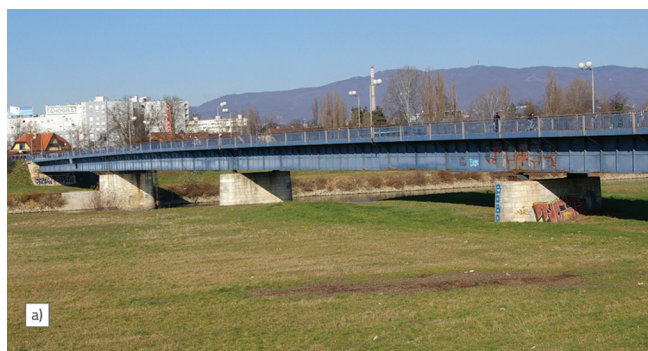
Slika 2. Most na Savskoj cesti u Zagrebu: a) pogled na most; b) osnovna skica
