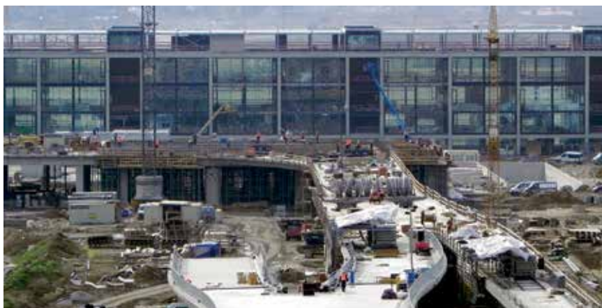
Intenzivni radovi na prilaznim cestama i tunelima 2010. godine
