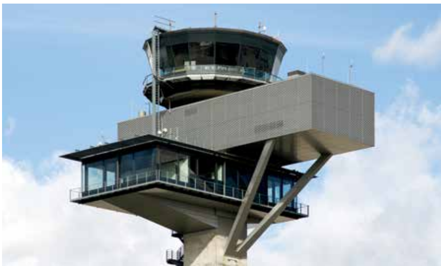
Novi toranj za kontrolu leta
