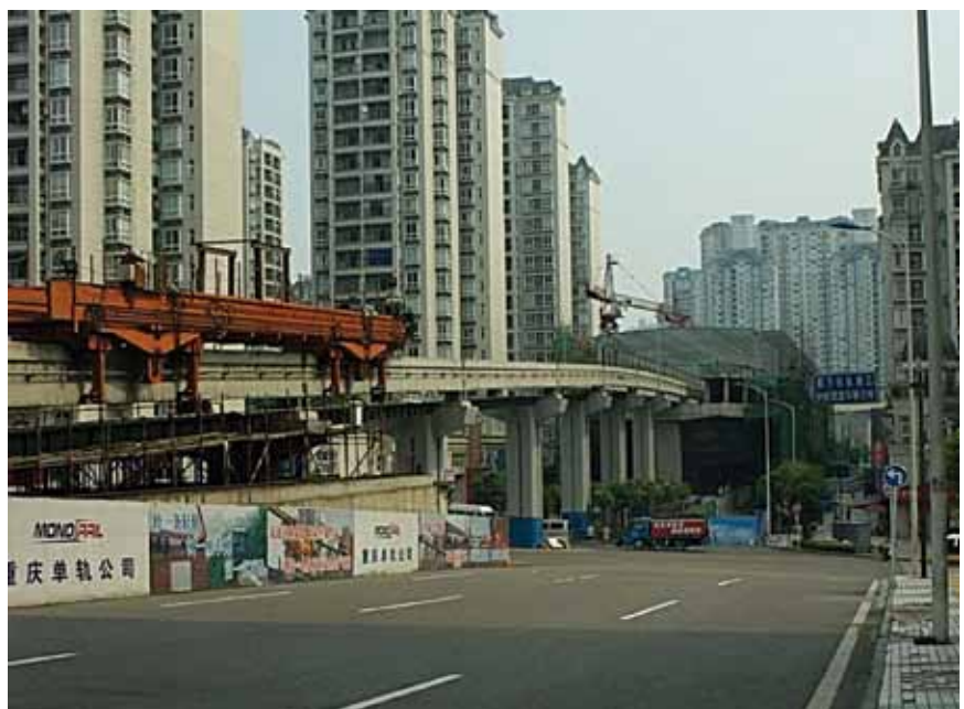
Gradnja nadzemnog dijela jednotračničke gradske željeznice
