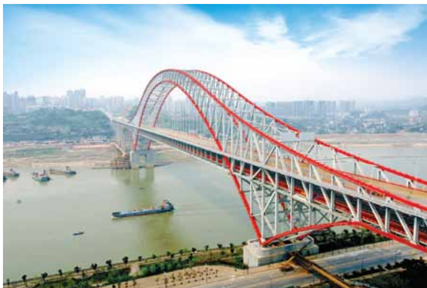
Gradnja čeličnoga rešetkastog mosta preko rijeke Jangce
