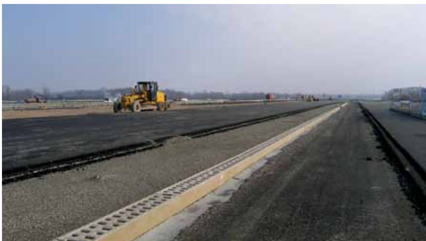
Gradilište novoga cestarskog prolaza južno od autoceste
