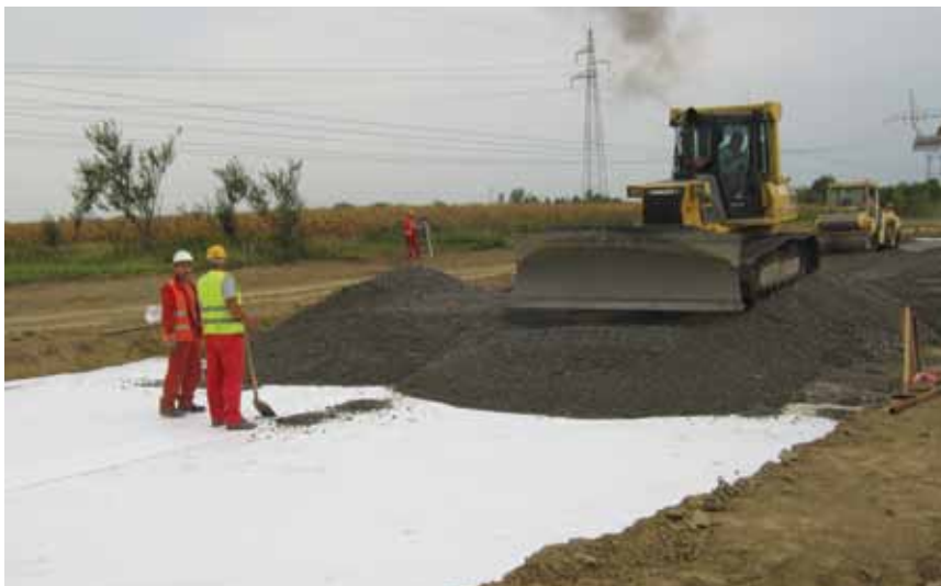
Nasip za novi paralelni kolnik u čvoru Ivanja Reka
