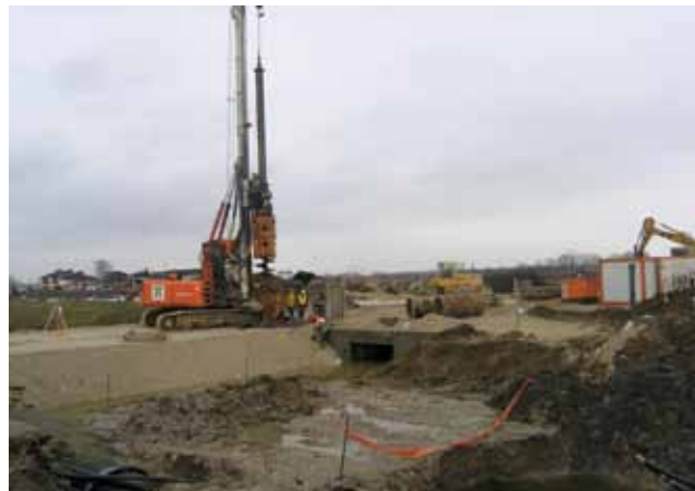
Ugradnja bušenih pilota na mostu preko kanala
