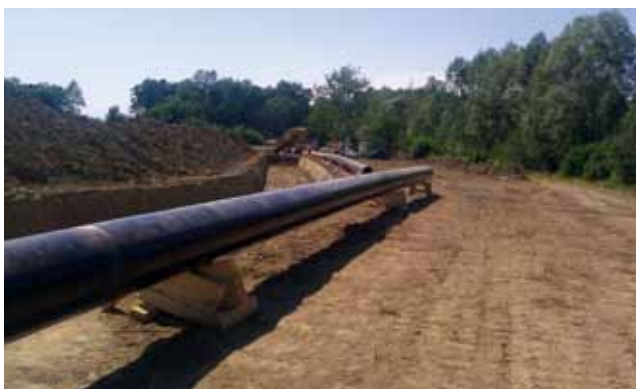
Izmještanje instalacija na mjestu novoga čeonoga cestarskog prolaza
