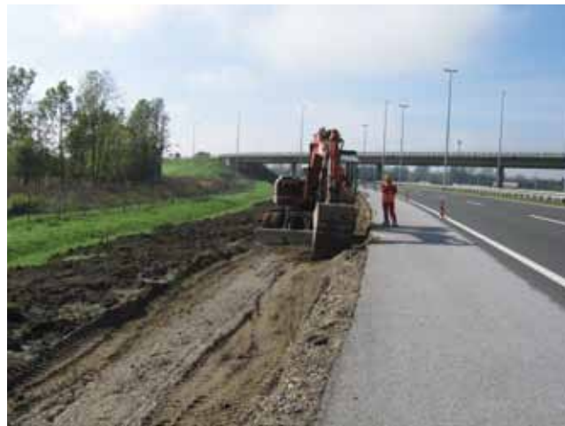
Radovi u čvoru Ivanja Reka
