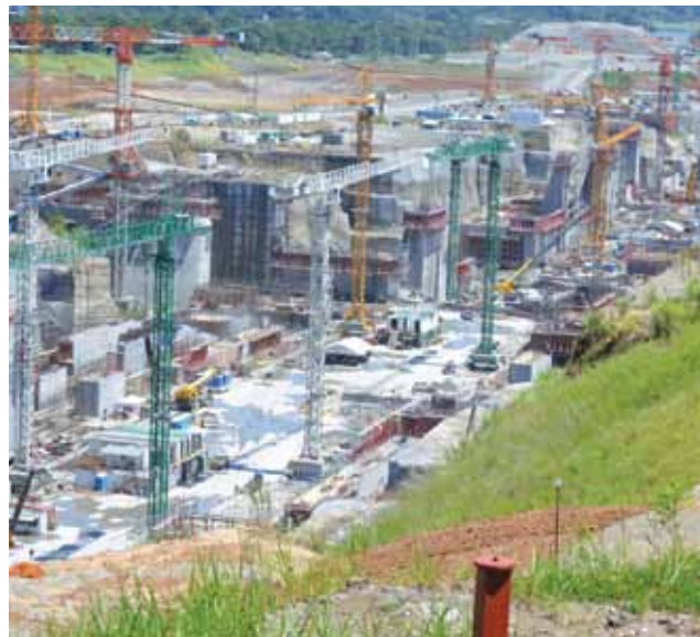
Veliki iskopi i armiranobetonski zahvati
