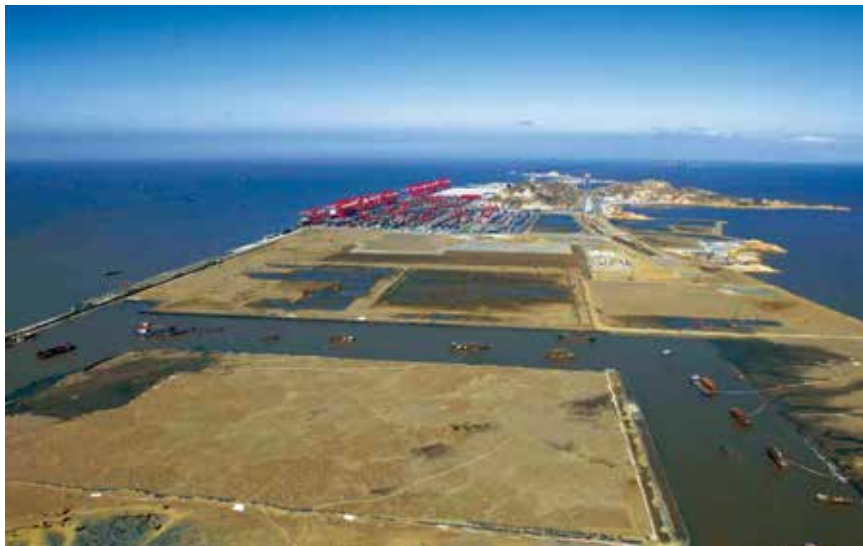
Pogled iz zraka na gradilište luke Yangshan
