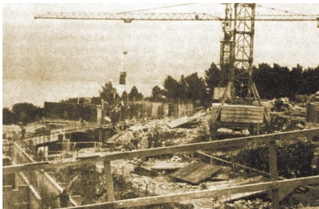
Detalj s gradilišta (slika iz članka)
