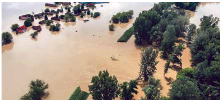
Lokacija proboga lijevoobalnog nasipa u Rajevu Selu 20. svibnja 2014.
