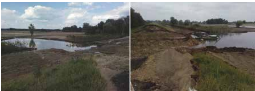
Pogled s krune nasipa na mjesto proboja i depresiju uzvodno i nizvodno od proboja u Račinovcima
