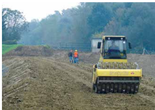
Obnova nasipa u Račinovcima
