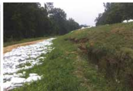
Saniranje nasipa u Topoli (lijevo) i mjesto procjeđivanja uzvodno od čuvarnice u Topoli (desno)
