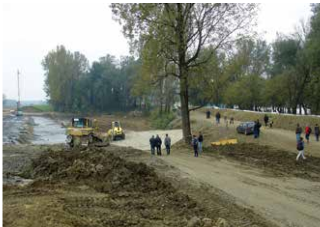
Obnova nasipa u Rajevu Selu
