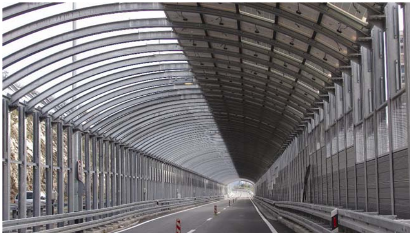
Dio novoizgrađene riječke obilaznice
